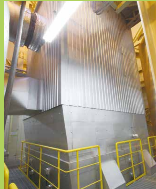
■ろ過式集じん器 排ガスに含まれる細かいばいじん及び重金属類を集じんろ布(フィルター)で捕集します。
