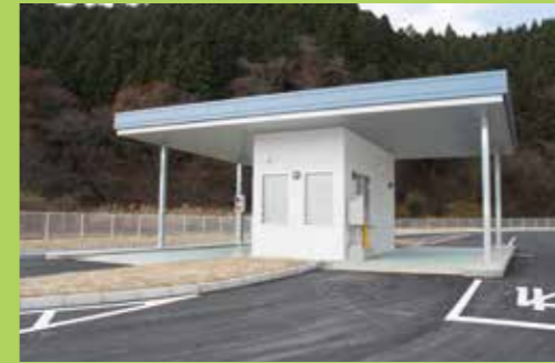
■計量機 収集されたごみを入場時に自動的に計量・記録し、集中管理します。
