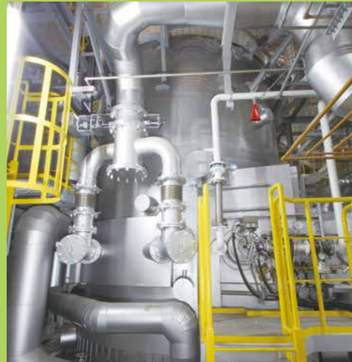
■燃焼室 熔融炉から発生した熱分解ガスを燃焼室で完全燃焼し、ボイラに送ります。
