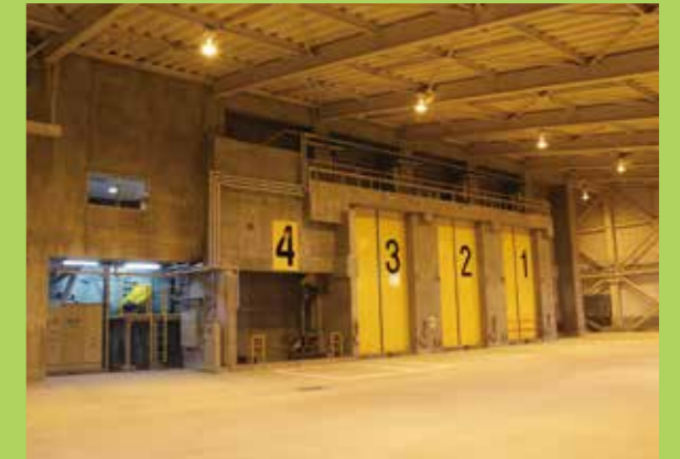
■プラットフォーム ごみ収集車は計量機で重さを量ってからプラットフォームに入場し、投入扉からごみピットにごみを投入します。
